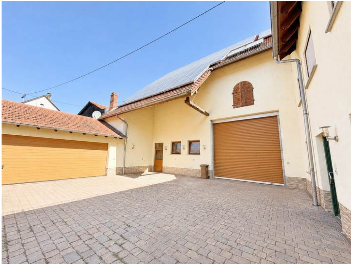
Großer Hof und Ansicht der Doppelgarage und Scheune
