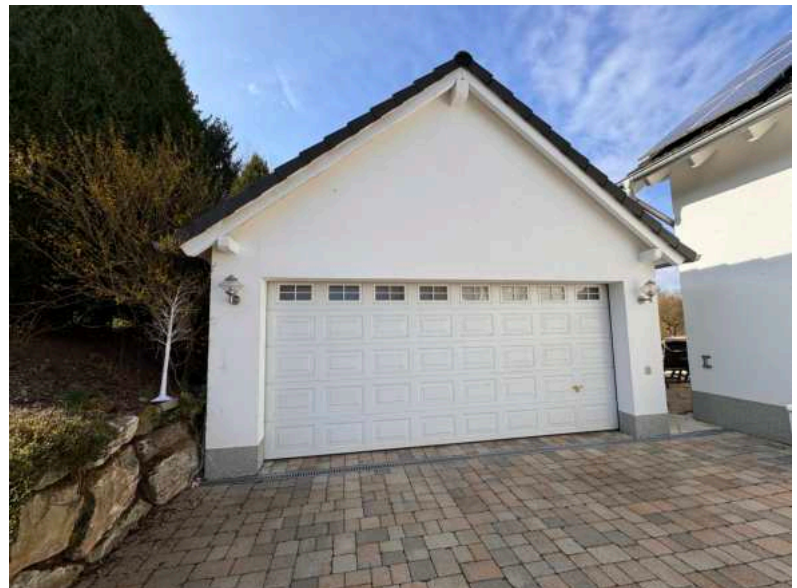
Große Doppelgarage mit elektrischem Garagentor per Code oder Fernbedienung
