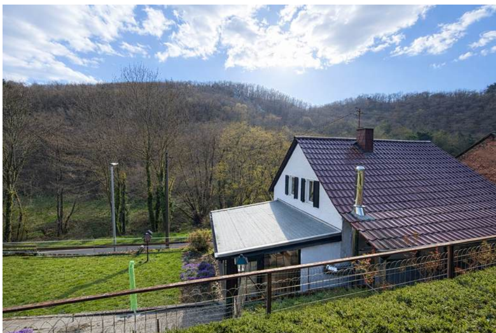
Weitere Ansicht vom Haus Dach in sehr gutem Zustand
